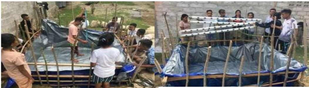
Gambar 2. Pemasangan Terpal dan Pipa
