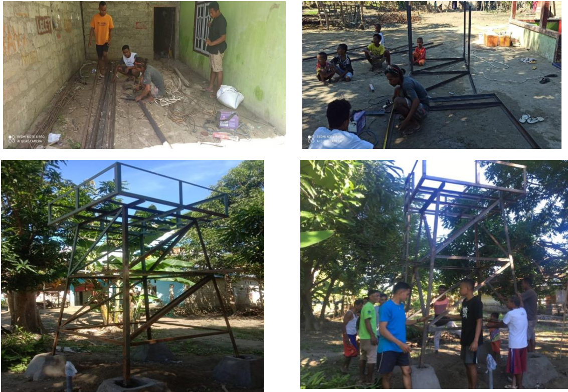
Gambar 1 Foto Pekerjaan Menara
