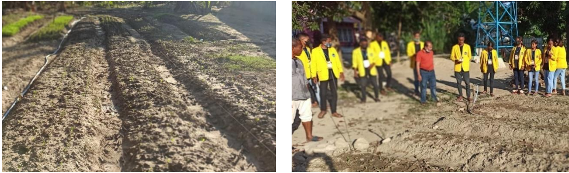
Gambar 7. pengerjaan bangunan WC hingga pemangan instalasi air.
