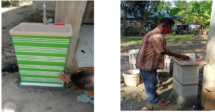
Gambar 5. Pembuatan Wastafel Jemaat dan Instalasi Air WC
