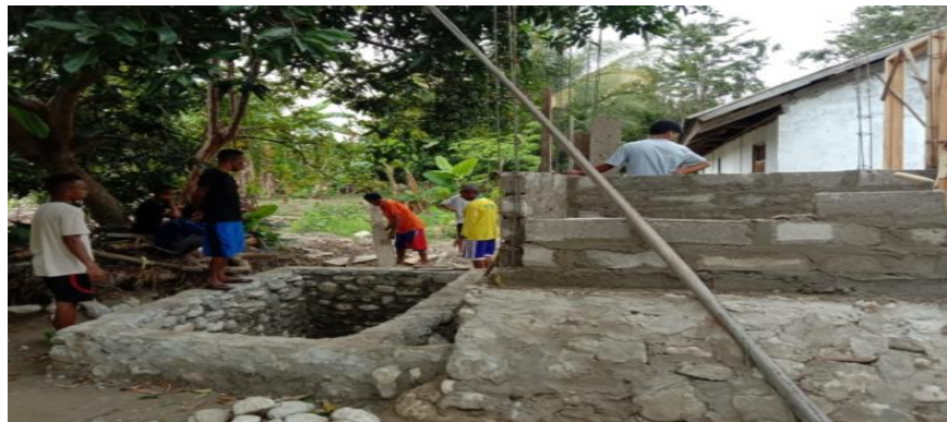
Gambar 6. pengerjaan bangunan WC hingga pemangan instalasi air.
