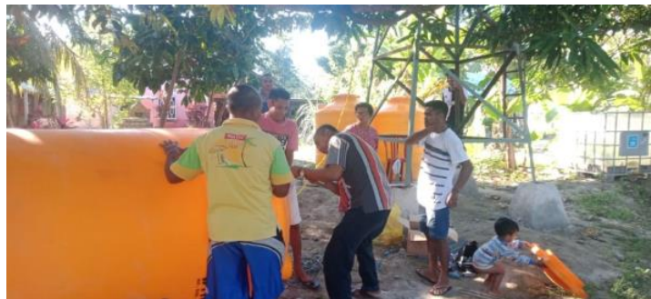
Gambar 3. Pembuatan Jaringan Instalasi Pompa dan Instalasi Listrik
