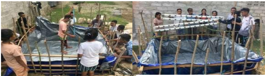
Gambar 2. Pemasangan Terpal dan Pipa
